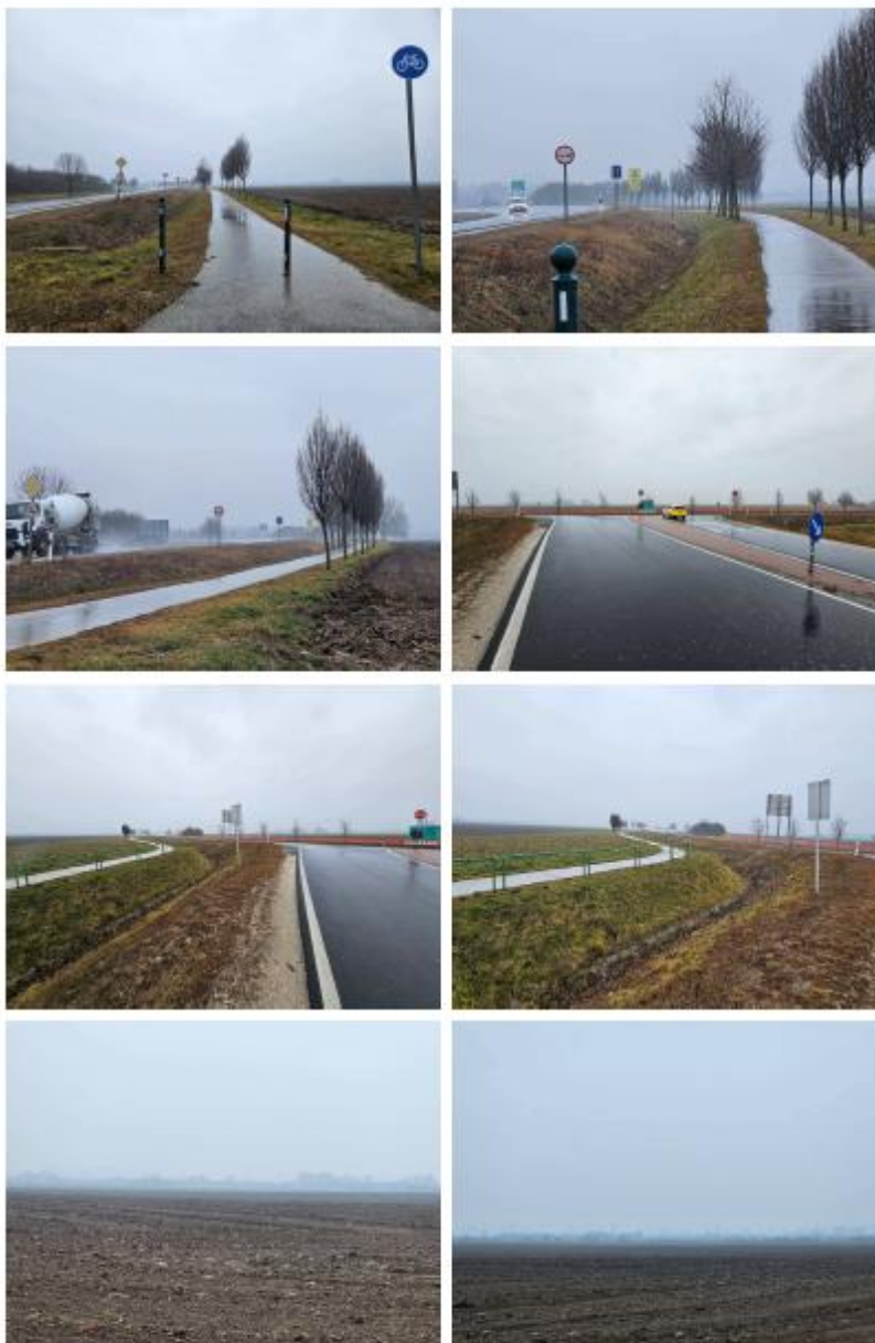
88-as főút 88100 bek. út csomópontja felől fényképezve
