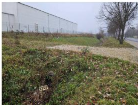
Meglévő árok feletti útcsatlakozás a 3868/21 hrsz déli végénél
