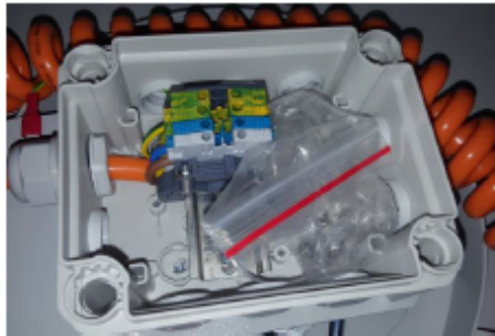
2. Szekrény 230V-os betáplálás bekötésére szolgáló kötődoboz
