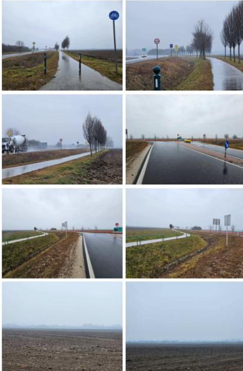
88-as főút 88100 bek. út csomópontja felől fényképezve
