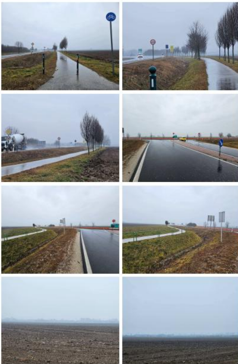
88-as főút 88100 bek. út csomópontja felől fényképezve
