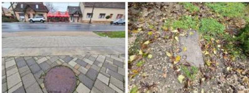
Az Aranyos ér tisztító nyílása baira a Rákóczi úton az 1189 hrsz ingatlanon, illetve jobbra a 821/2 hrsz ingatlan mögött az 1106 hrsz-en.
