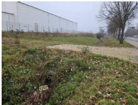
Meglévő árok feletti útcsatlakozás a 3868/21 hrsz déli végénél
