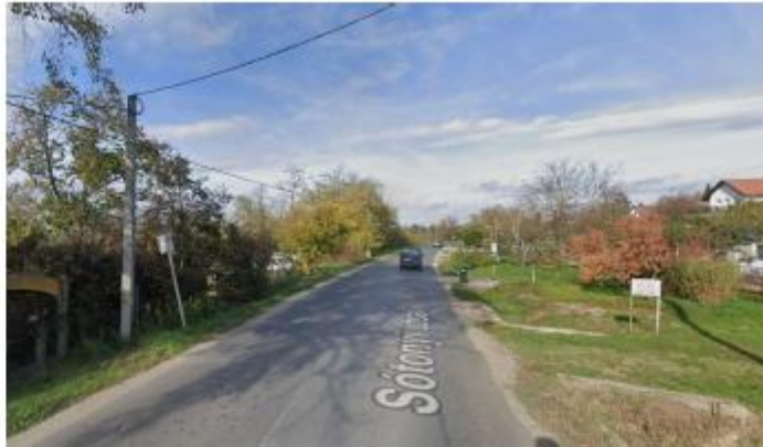
Meglévő Sótorny út fényképe
