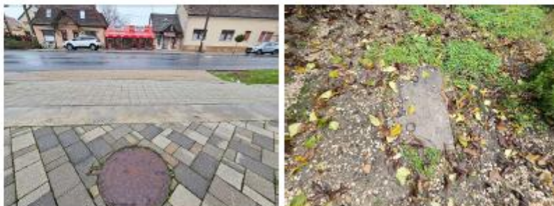
Az Aranyos ér tisztító nyílása bairra a Rákóczi úton az 1189 hrsz ingatlanon, illetve jobbra a 821/2 hrsz ingatlan mögött az 1106 hrsz-en.
