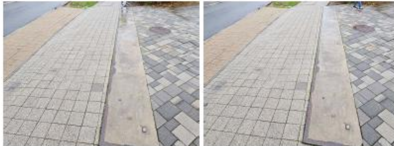
Híd korlát helye a Rákóczi utca déli oldalán
