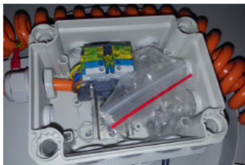
2. Szekrény 230V-os betáplálás bekötésére szolgáló kötődoboz
