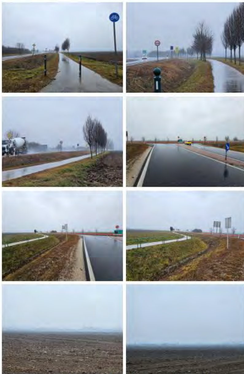
88-as főút 88100 bek. út csomópontja felől fényképezve
