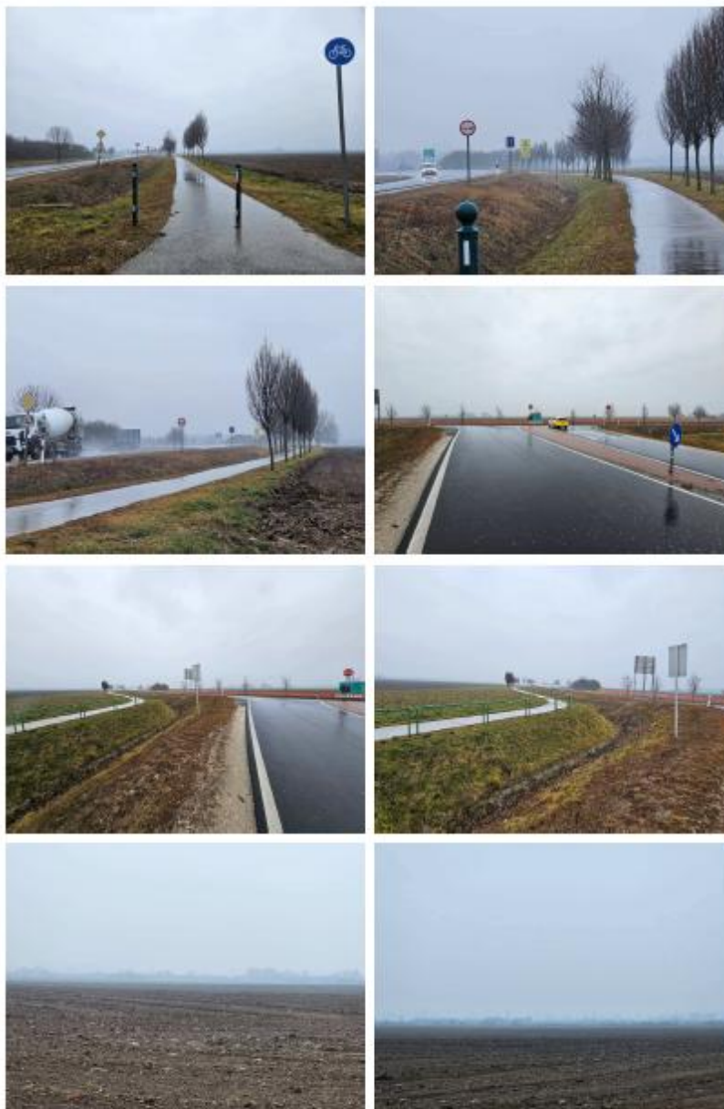
88-as főút 88100 bek. út csomópontja felől fényképezve
