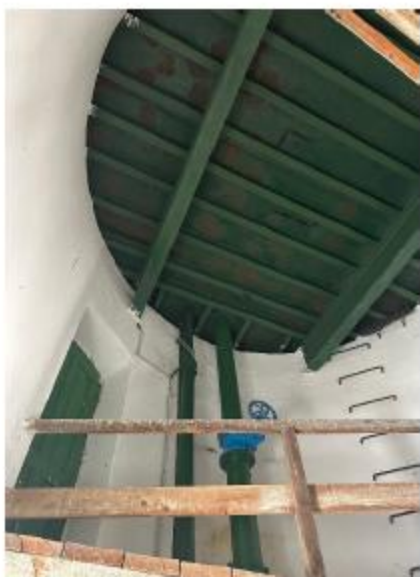
Utólagosan kialakított fogadószint, I acélgerendákon nyugvó bordázott fémlemez.
