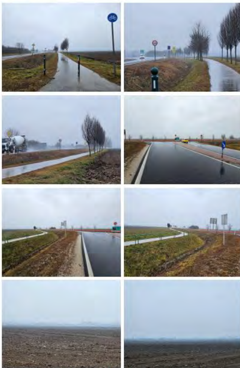
88-as főút 88100 bek. út csomópontja felől fényképezve
