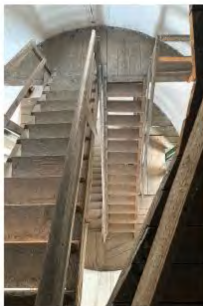
Utólagosan kialakított fogadószint, I acélgerendákon nyugvó bordázott fémlemez.
