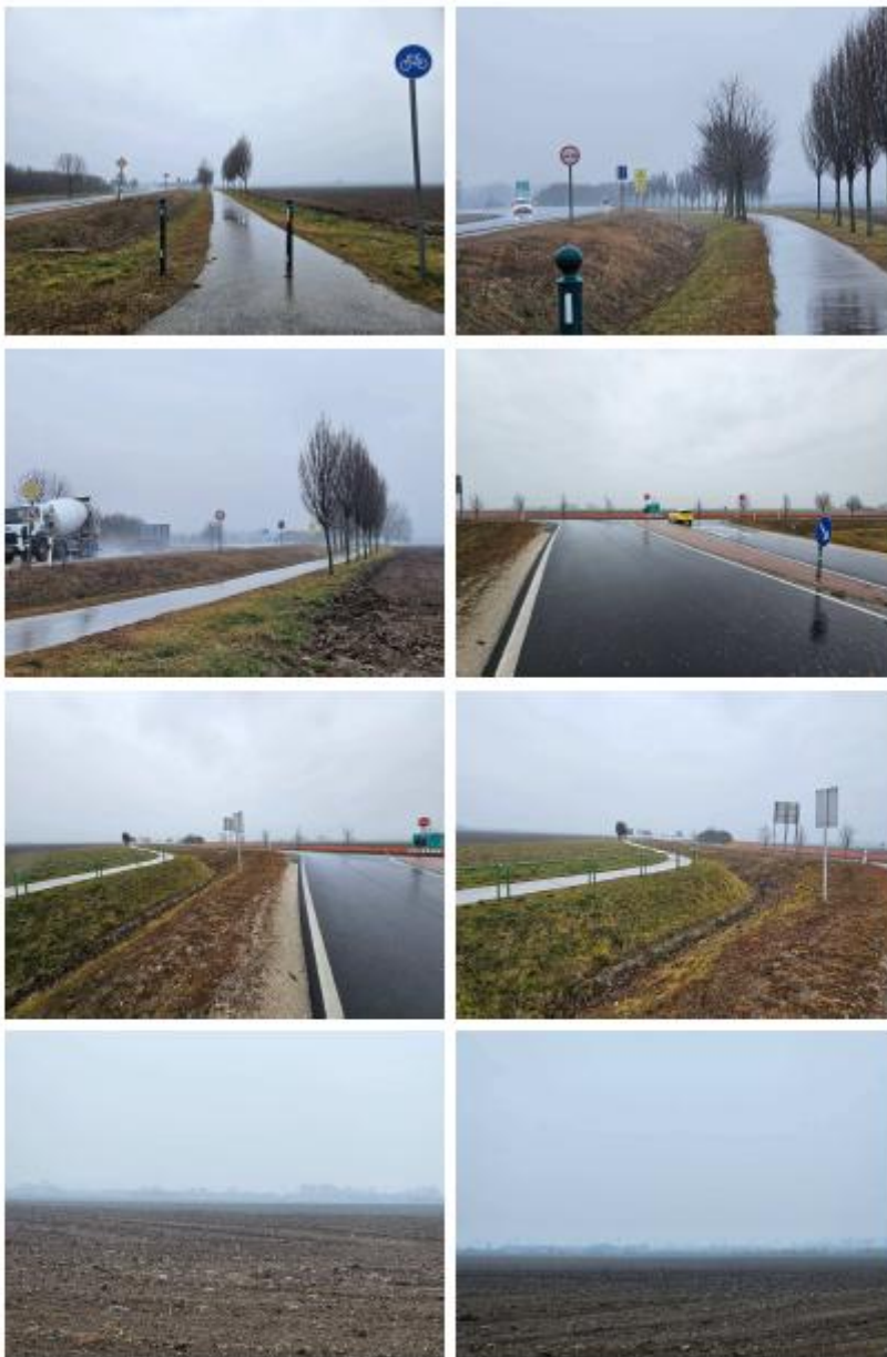
88-as főút 88100 bek. út csomópontja felől fényképezve
